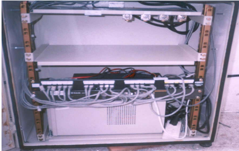
figura 7.5 Disposición física del swicht y la UPS
