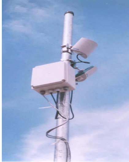
figura 7.3 Disposición física de las antenas y los access points
